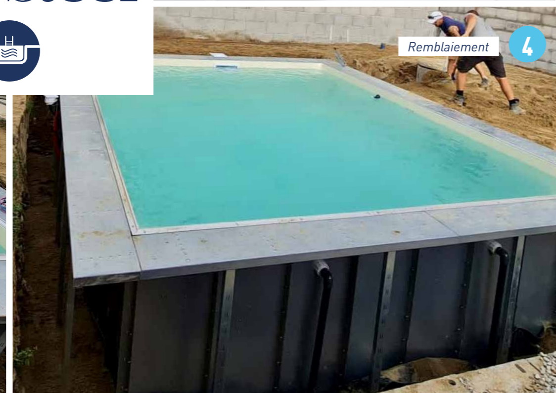
Mise en place des panneaux et supports margelles
