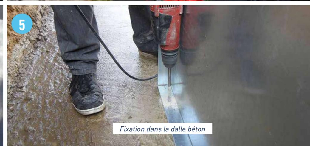
Fixation dans la dalle béton
